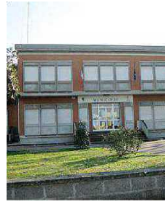
Il municipio di Vigarano Mainarda
