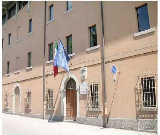
La sede dell'Unione dei Comuni del Frignano a Pavullo
