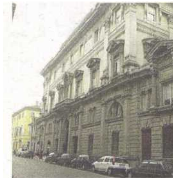
Palazzo della Provincia in via Garibaldi
