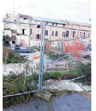
Il cantiere privato all'ex Milizia
