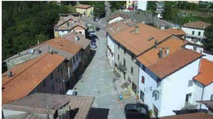
Il ponte della Roccaccia quando era aperto, Calbano e la piazza di Verghereto
