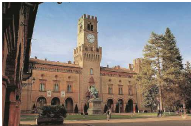
Unioni e fusioni Il palazzo municipale di Busseto.
